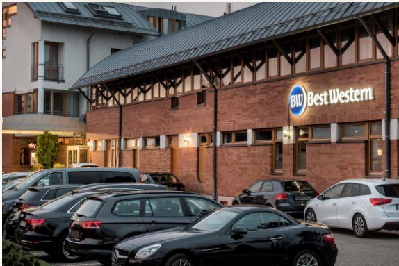
Außenansicht vom Parkplatz
